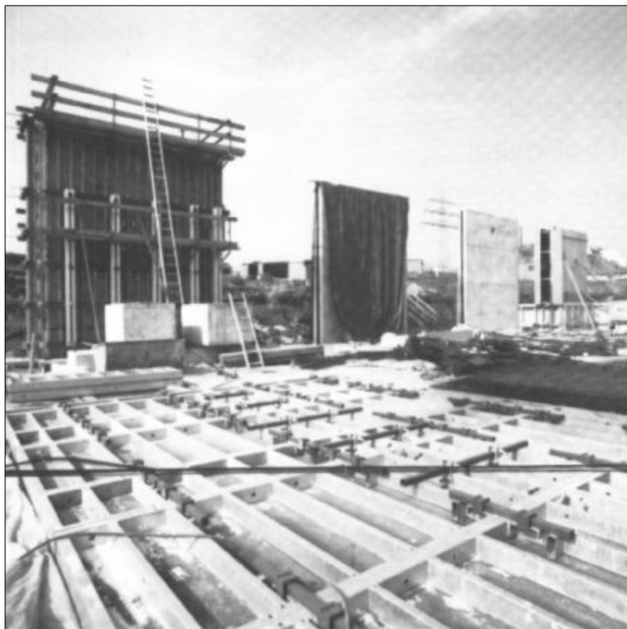
Taśma do spoin roboczych FIX 24 – pozioma w połączeniu ściana - dno – pionowa w ścianie zewnętrznej.
