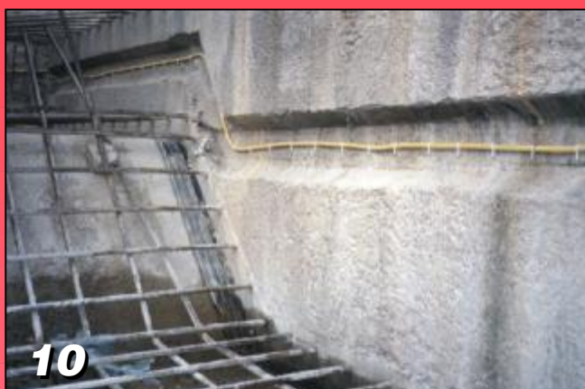
10 Połączenia płyt fundamentowych ze ścianami szczelinowymi
