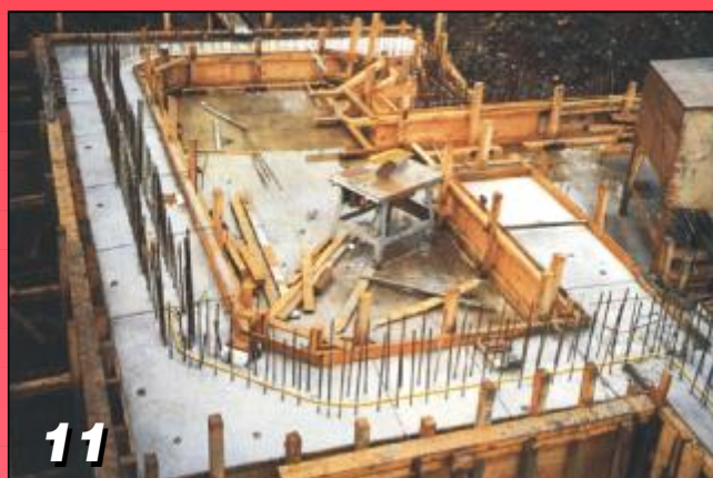
11 Styki płyt fundamentowych ze ścianami
