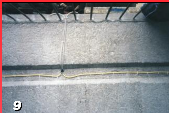
9 Przerwy robocze płyt fundamentowych
